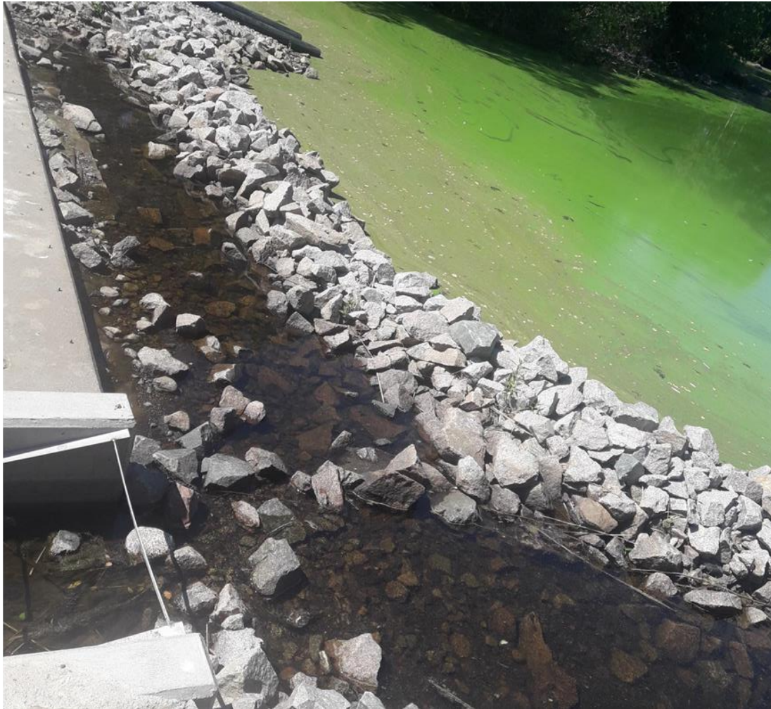
Foto 9. Dammen mellan Bergundasjöarna i juli 2018. Notera den påtagligt bättre vattenkvaliteten i Södra Bergundasjön (närmast i bild). Dammen har två syften: att hindra bakåtströmning av vatten från Norra Bergundasjön till Södra Bergundasjön i samband med mycket låga flöden och/eller blåst, samt -viktigare- att minimera migration av fisk. En permeabel stenvall uppfördes under våren 2018 istället för 15 mm galler, eftersom det uppstod problem med dödlighet av framför allt abborre på gallret pga för höga vattenhastigheter genom detsamma.
