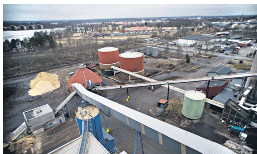
Ci-contre, la centrale à biomasse de Sandvik. Au dessus, les tapis qui transportent les déchets de bois jusqu'à la chaudière. En bas, les bassins de décantation de l'usine de traitement des eaux usées de Sundet.
