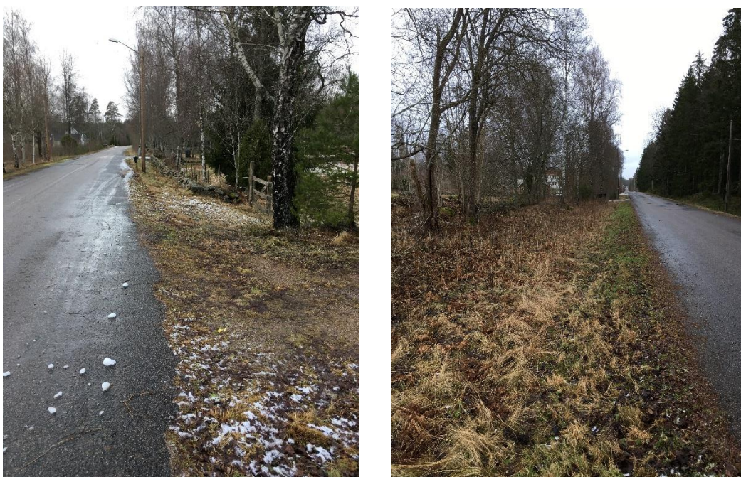
Bilder utmed gamla Växjövägen som visar på marknivåer kring vägsälant. Västerut t.v. och österut t.h.
