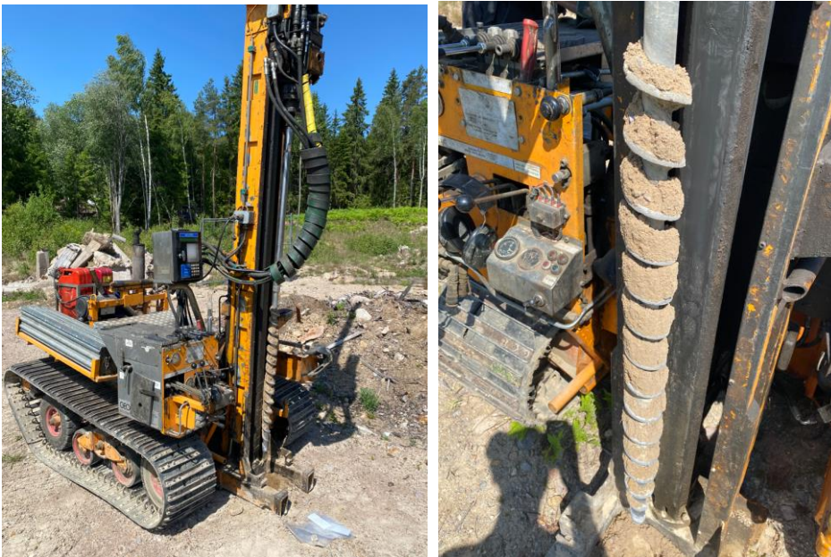
Figur 3. Bild från provtagning med skruvborr monterad på borrhandsvagn. © Sweco, 2023.
