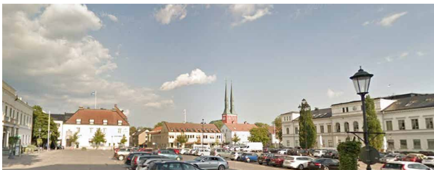
Vy från Kungsgatan mot Lejonet 5. (Google, 2019-10-22). I stadsrummet upplevs främst äldre bebyggelse från 1800-talsamtidigt 1900-tal. Strukturen kan uppfattas som relativt opåverkad av modernare bebyggelse. Domkyrkan utgör blickfång och det finns visuell kontakt med residens och andra offentliga byggnaders som kan läsas ihop med uttrycken för riksintresset.
