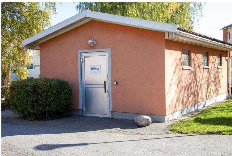
Figur 2 Avfallsrum med ljusinsläpp.
